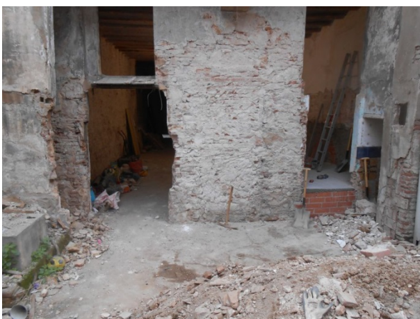
FOTO 19. Emplaçament del fossat de la maquinària de filtratge
