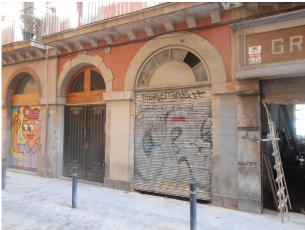
FOTO 3. Façana de l'immoble
