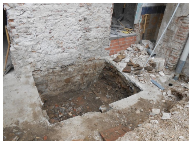
FOTO 20. Tasques d'excavació del fossat de la maquinària de filtratge
