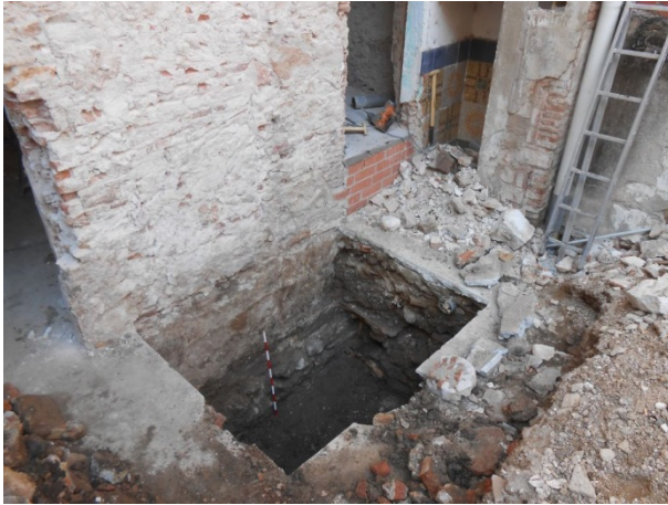
FOTO 23. Vista general del fossat un cop executat
