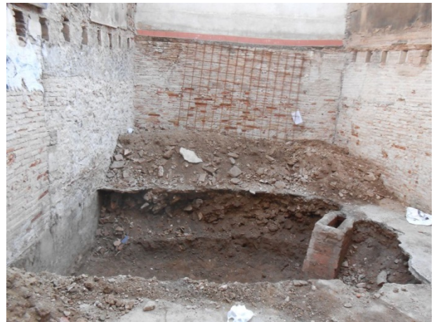
FOTO 6. Situació del fossat de la piscina abans del control arqueològic
