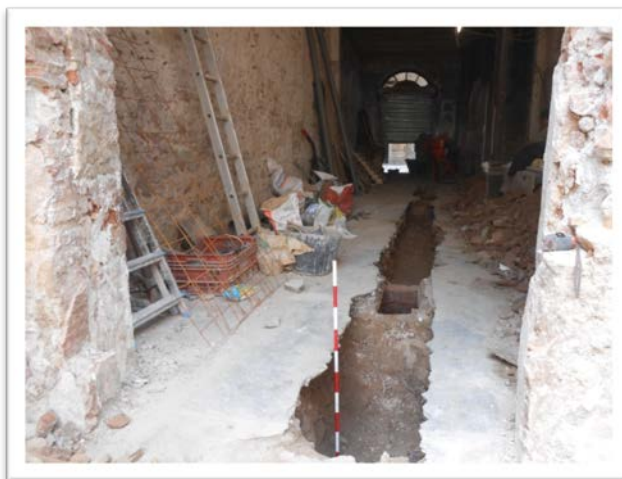
Imatge 3. Rasa de sanejament a l'interior de la finca
