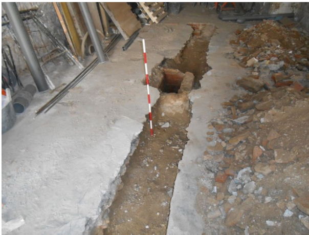
FOTO 27. Vista general de la rasa de sanejament
