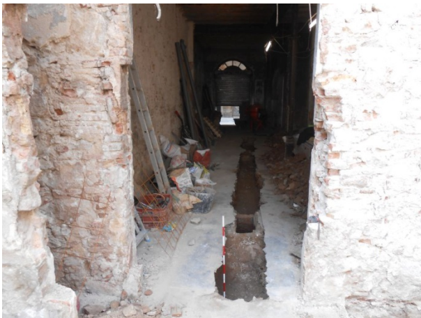
FOTO 25. Vista general, des del pati, de la rasa de sanejament
