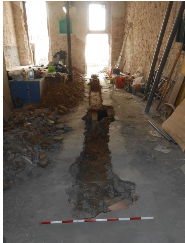
FOTO 28. Vista general, cap al pati, de la rasa de sanejament
