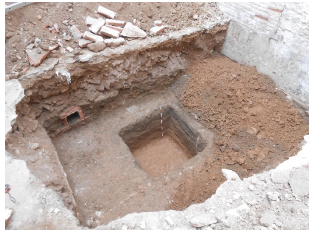
FOTO 12. Vista general de la cala de comprovació
