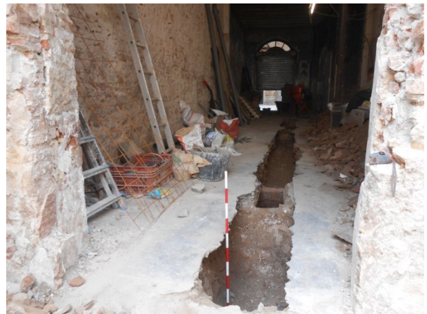
FOTO 26. Vista general de la rasa de sanejament
