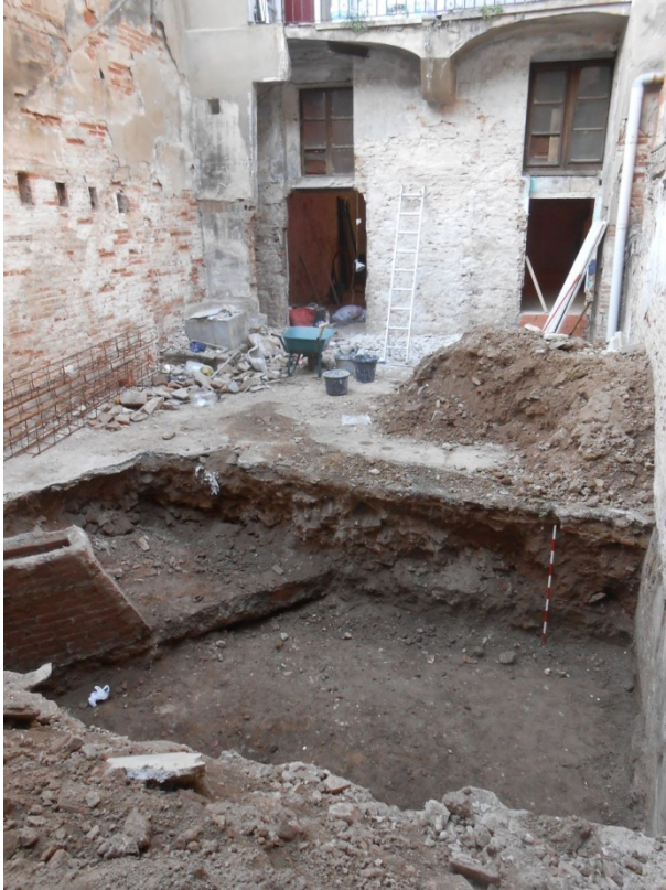
FOTO 5. Situació del fossat de la piscina abans del control arqueològic
