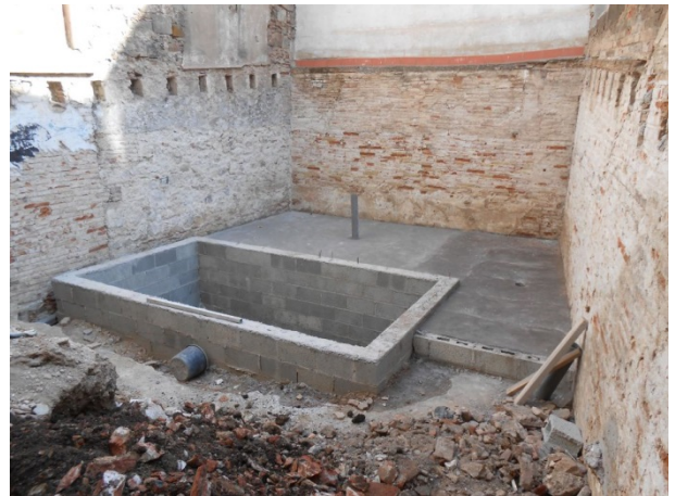
FOTO 18. Vista general del la piscina un cop executada
